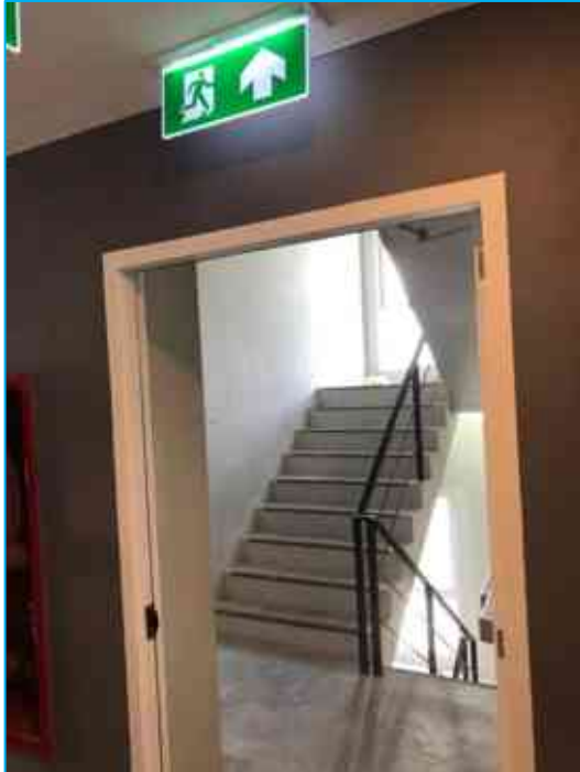
ภาพที่ 2-4(4.5-5) ไฟส่องสว่างฉุกเฉิน
