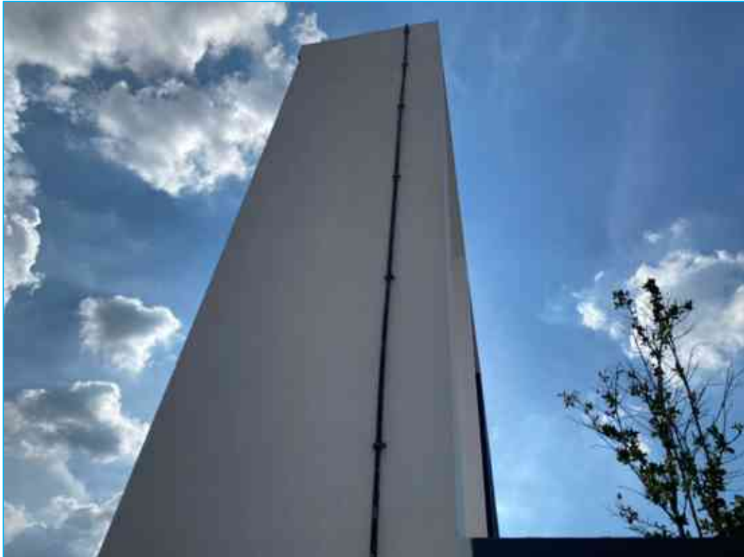
ภาพที่ 2-4(4.5-13) ระบบป้องกันอันตรายจากฟ้าผ่า
