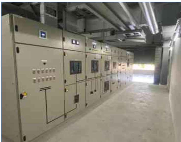
ภาพที่ 3-8(8.2) ช่างอาคารตรวจเช็ค ห้อง MDB ทุกวัน และ test run ระบบทุกวันพุธ เวลา 10.00 น. ประมาณ 15 นาที
