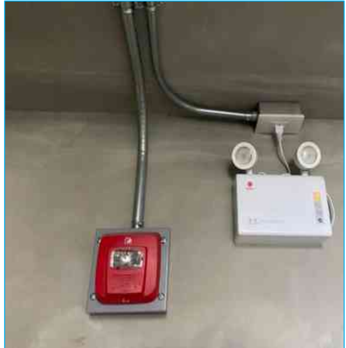
ภาพที่ 2-4(4.5-5) ไฟส่องสว่างฉุกเฉิน
