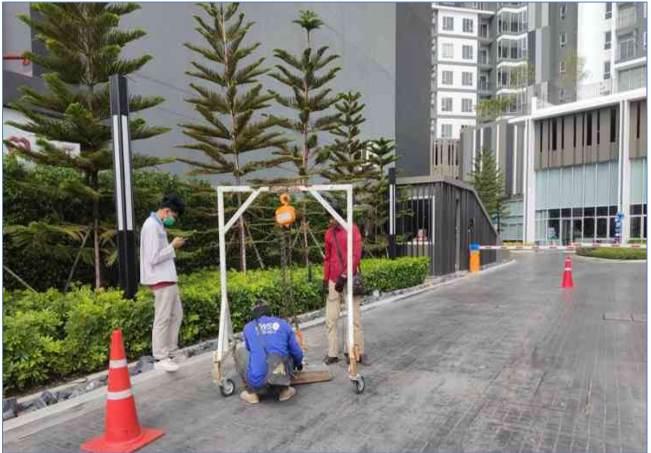
ภาพที่ 3-2(2.1) ช่างอาคารตรวจสอบบ่อพักน้ำเดือนละ 1 ครั้ง ถ้ามีตะกอนให้สูบตะกอนทิ้ง (ต่อ)
